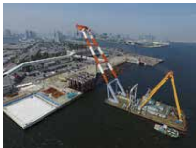
～岸壁棧橋の整備状況～
