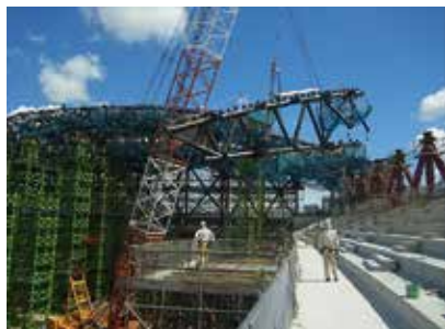
～都内アリーナの建設状況～
