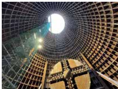
～シールドマシンによる雨水幹線（地下24m）の掘進～
