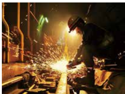
～都営大江戸線レール交換状況～
