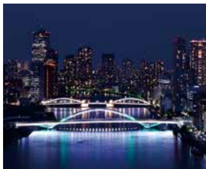
～隅田川橋梁群～
