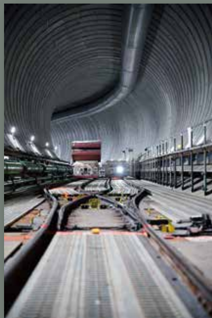
【作品名】東京強靱化プロジェクト ～地下調節池トンネルの造形美・曲線美～
